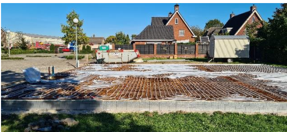
6 september: slangen vloerverwarming plaatsen
