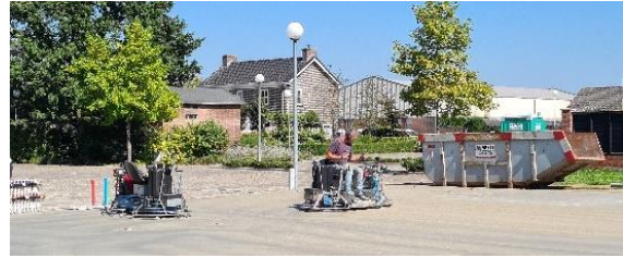
7 september: beton storten en vlinderen
